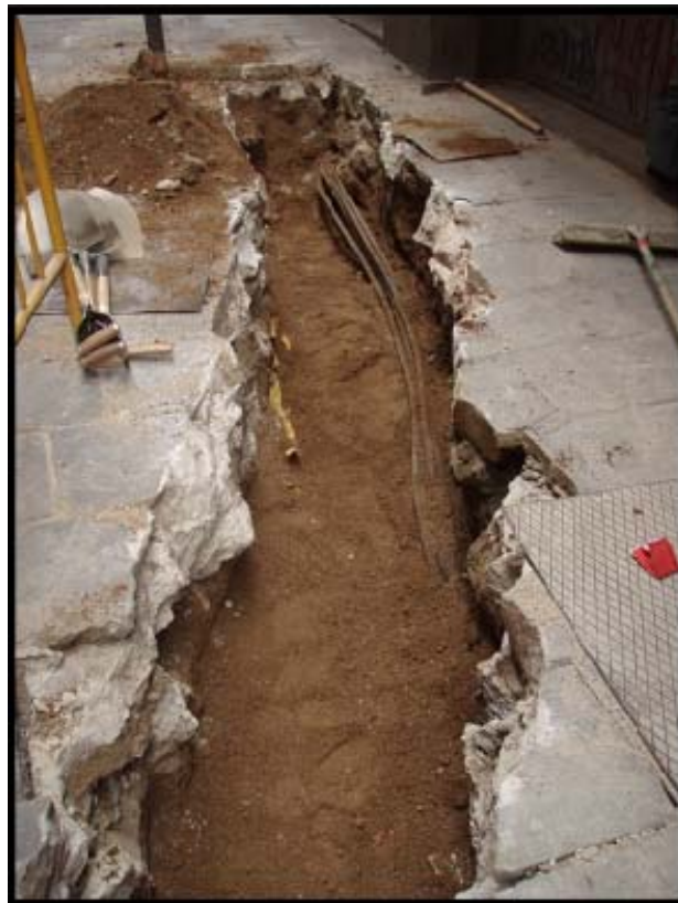
Tram de la rasa 200
