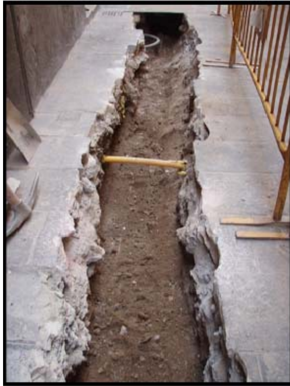
Tram de la rasa 100
