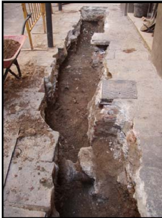
Tram de la rasa 100
