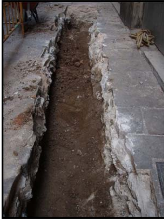
Tram de la rasa 100
