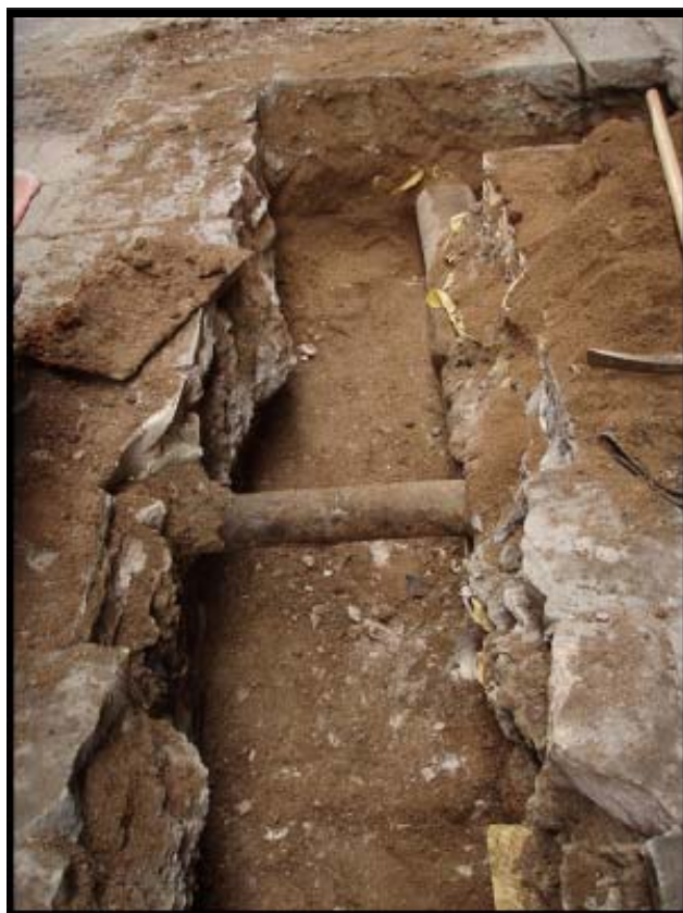
Tram de la rasa 200
